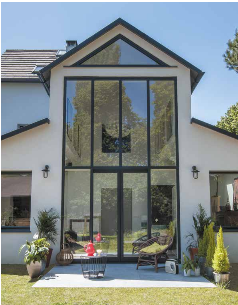
Porte-fenêtre intégrée dans un mur rideau, couleur gris 7016 satiné
