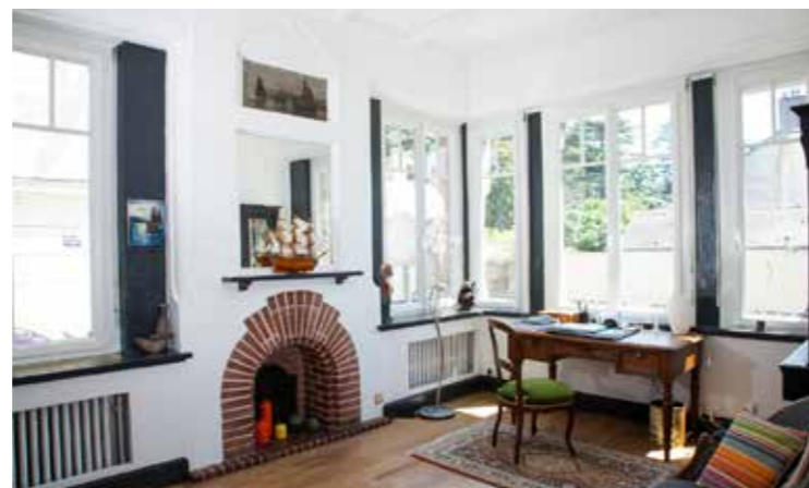
La nouvelle menuiserie est installée sans dégradation ni à l'intérieur, ni à l'extérieur et conserve son clair de vitrage maximum.
