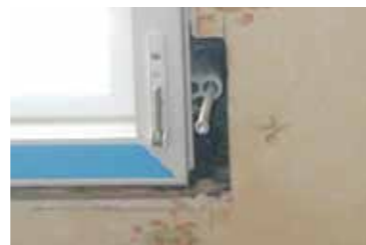
Présentation du dormant de la nouvelle menuiserie
