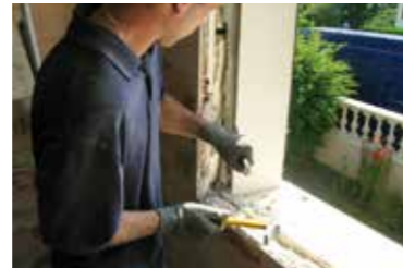
Dépose de l'ancienne menuiserie dans sa totalité : dormant et ouvrant
