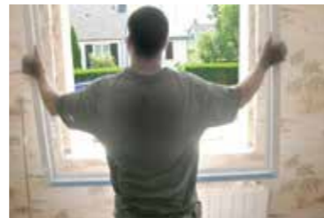
Présentation du dormant de la nouvelle menuiserie
