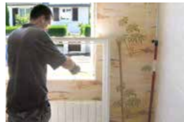
Présentation du dormant de la nouvelle menuiserie
